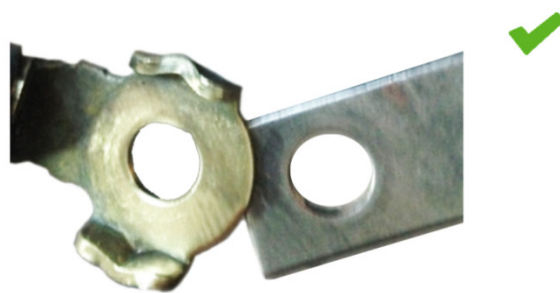
Fig. 2: conexión a masa después de la limpieza: buen contacto
